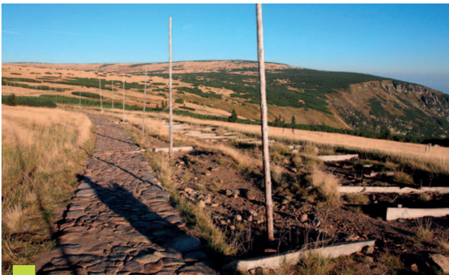
Wyremontowany szlak turystyczny nad Kotłem Małego Stawu i regeneracja roślinności w jego otoczeniu (AR)
