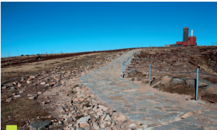
Nowa nawierzchnia szlaku nad Śnieżnymi Kotłami i barierki zabezpieczające murawy wysokogórskie przed wydeptywaniem (AR)
